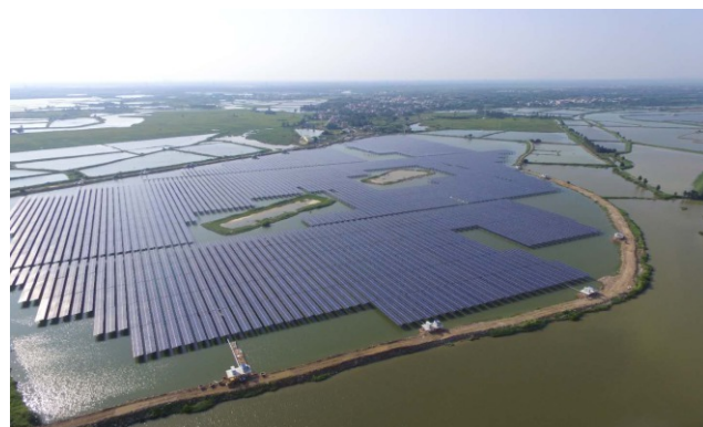
项目客户: 湛江20MWp渔光互补光伏发电项目 项目类型: 渔光互补光伏电站
