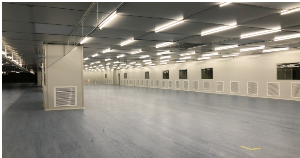
信利光电(仁寿)第5代 TFT-LCD Cleanroom, ISO class 5, TRULY G5 TFT-LCD project
