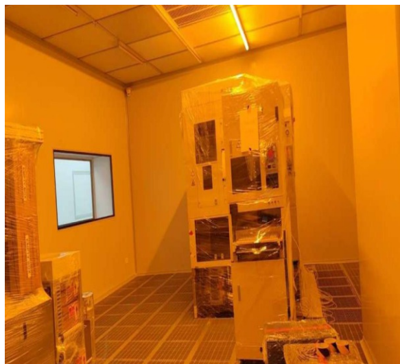
普福斯洁净区(黄光区) Cleanroom, ISO class 4
